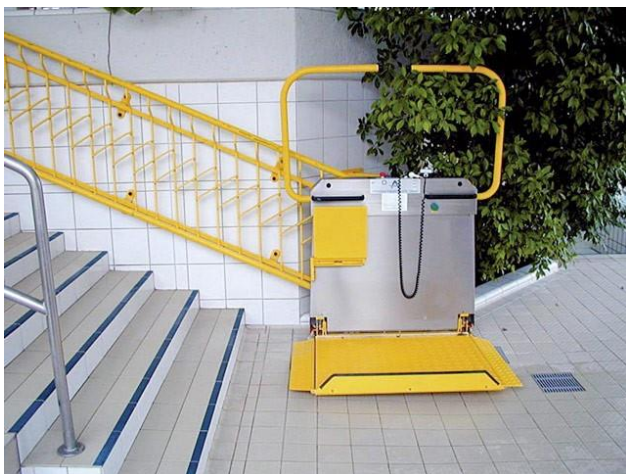
Obrázek 17: Vlevo: Příklad schodišťového výtahu; Vpravo: Model schodišťového výtahu.
